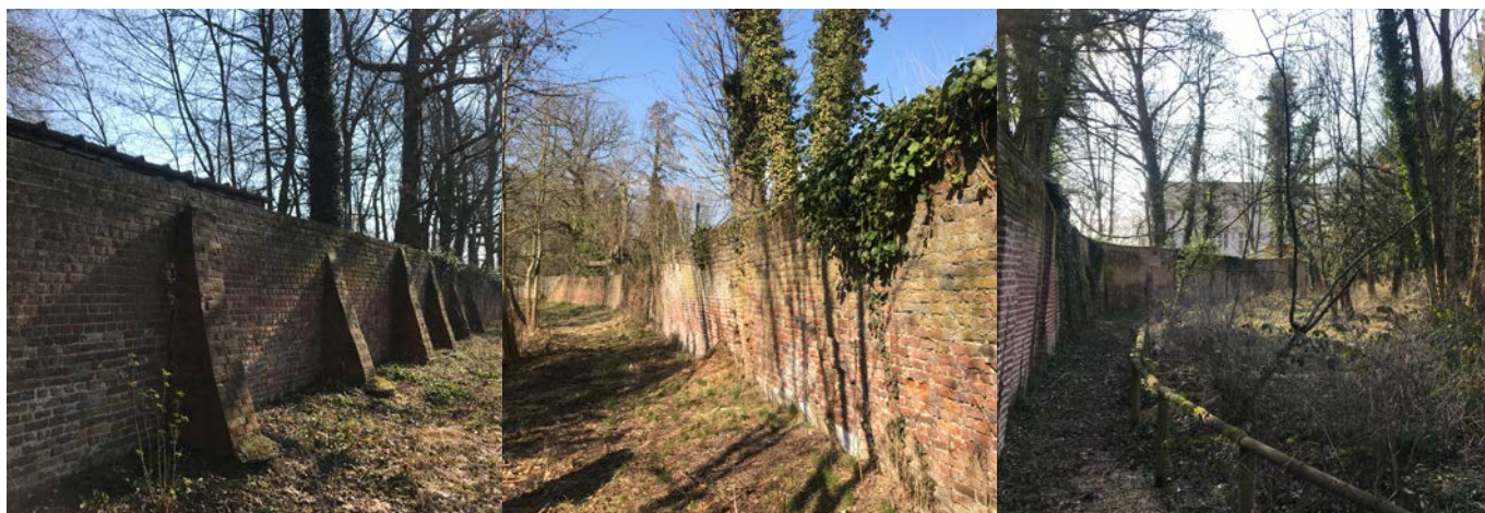
Chemin qui longe le mur d'enceinte de l'ancien site monastique
