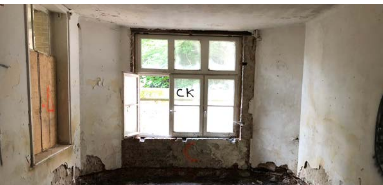
Emplacement du futur escalier d'accès sous-sol / rez-de-chaussée
