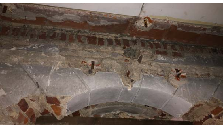
Anciennes moulures mises au jour
