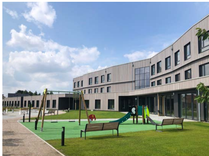
Vue d'ensemble de la façade Est
