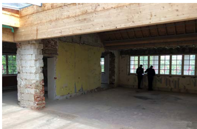
Démolition des cloisons récentes à l'étage
