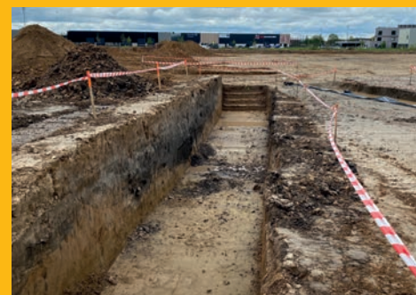
Vue pendant la fouille - site nouveau groupe scolaire privé (2024)
